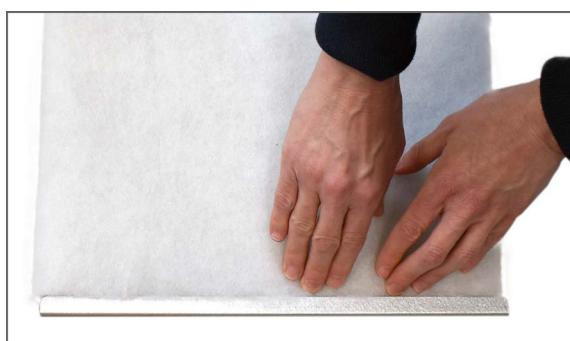
7. Filtermåtten klemmes omhyggeligt fast i filterrammen og skubbes godt ud til siderne. Filtret placeres igen i ventilationsaggregatet med filtermåtten opad.
