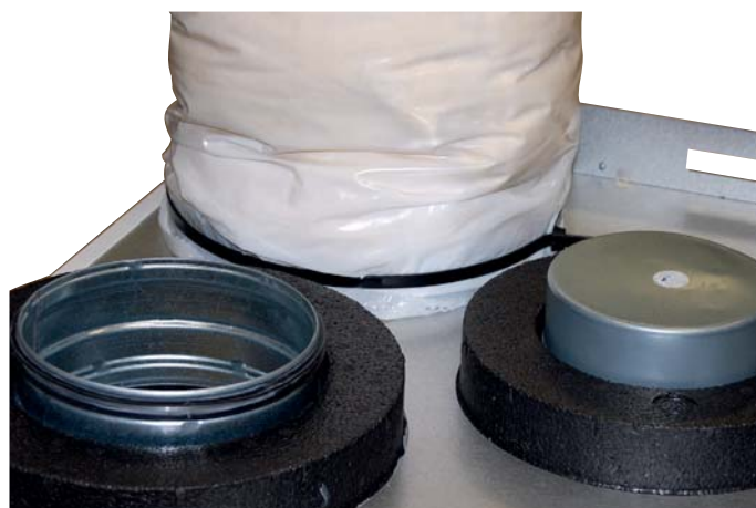
Figur 20 Ferdig montert kanal
